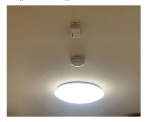
◆居室用人感センサーの取付位置 部屋の天井の中心付近に取り付け。
