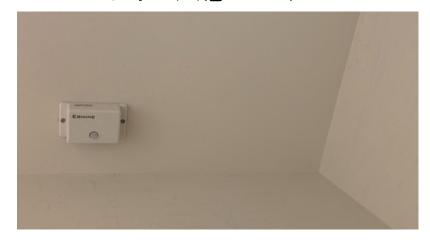
◆トイレ用人感センサーの取付位置 入口の外を人が歩いた時に 反応しない位置に取り付け。
